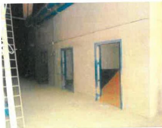
Photo 2 : Bâtiment d'exploitation Silos de stockage
